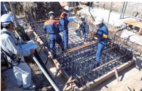
危険物タンクの基礎を検査する様子 ＝写真提供：東部消防局
