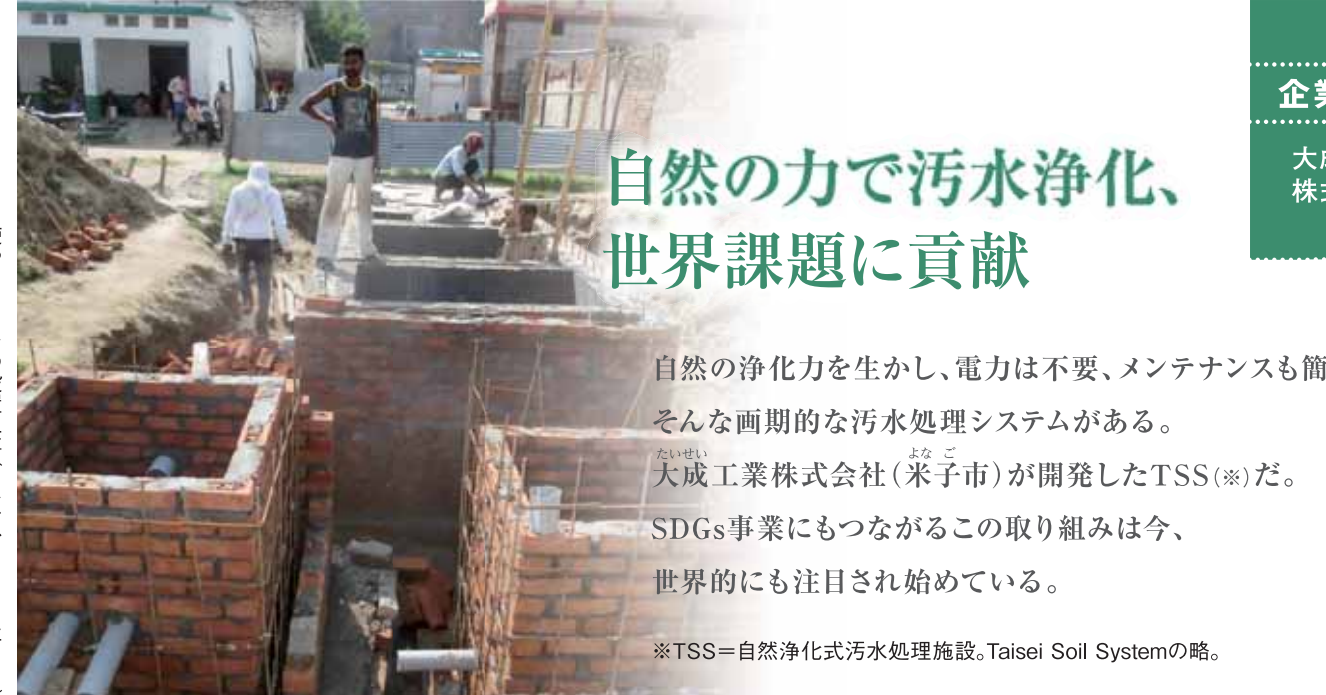
TSSを使ったトイレの設置工事(インド、2018年9月) 写真提供:大成工業
