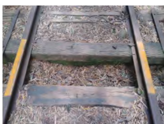
↑廃線から38年。枕木も当 時のまま残されている。
