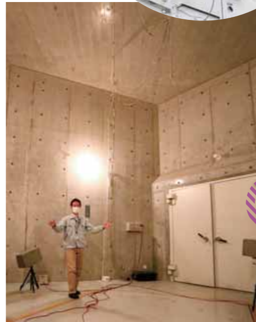
【残響室】 対面する壁が並行に作られていないため、音があちこちに反響する
